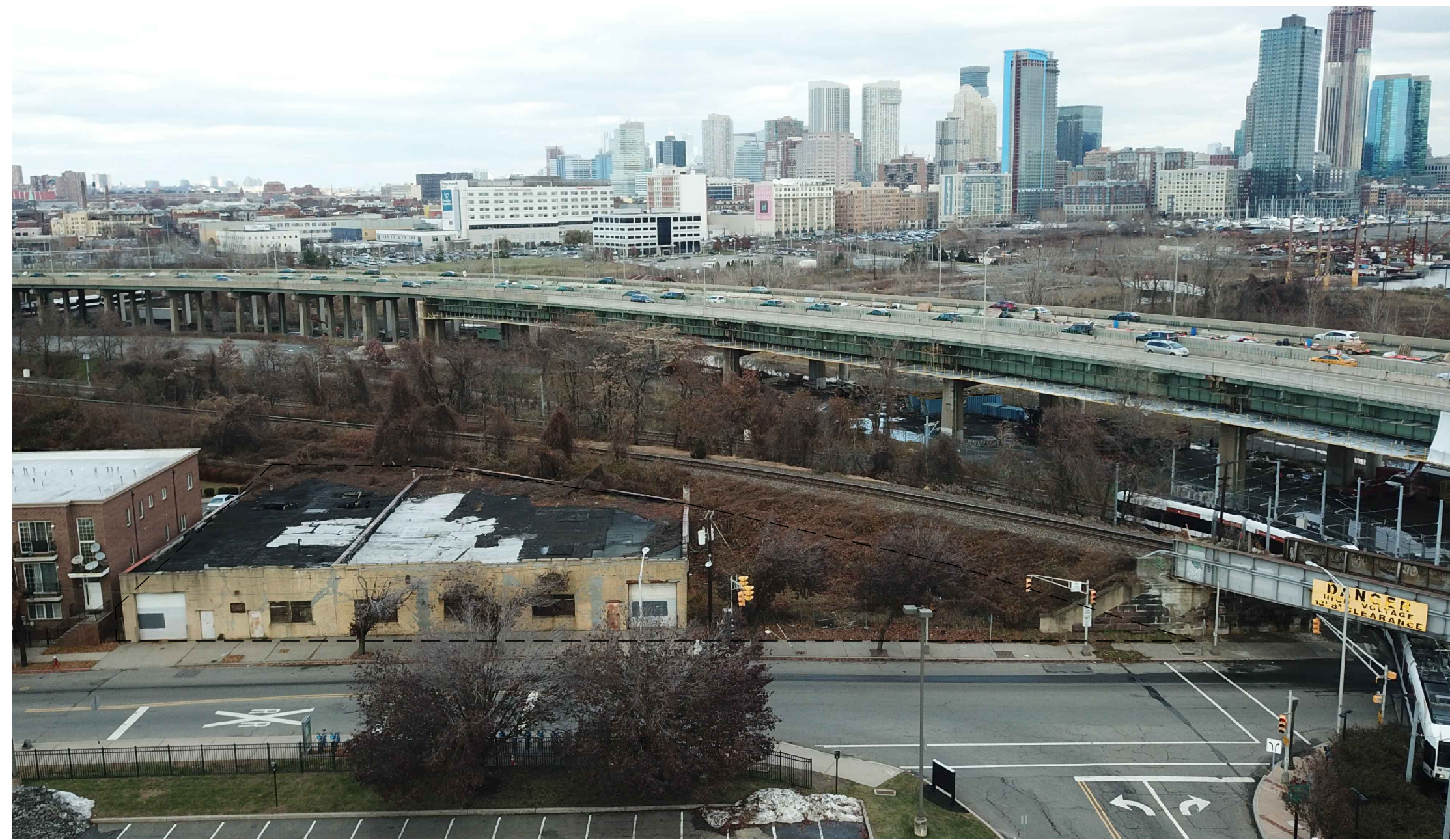
3 SITE PHOTO SOUTH (JOHNSTON AVE) SCALE: N.T.S.
