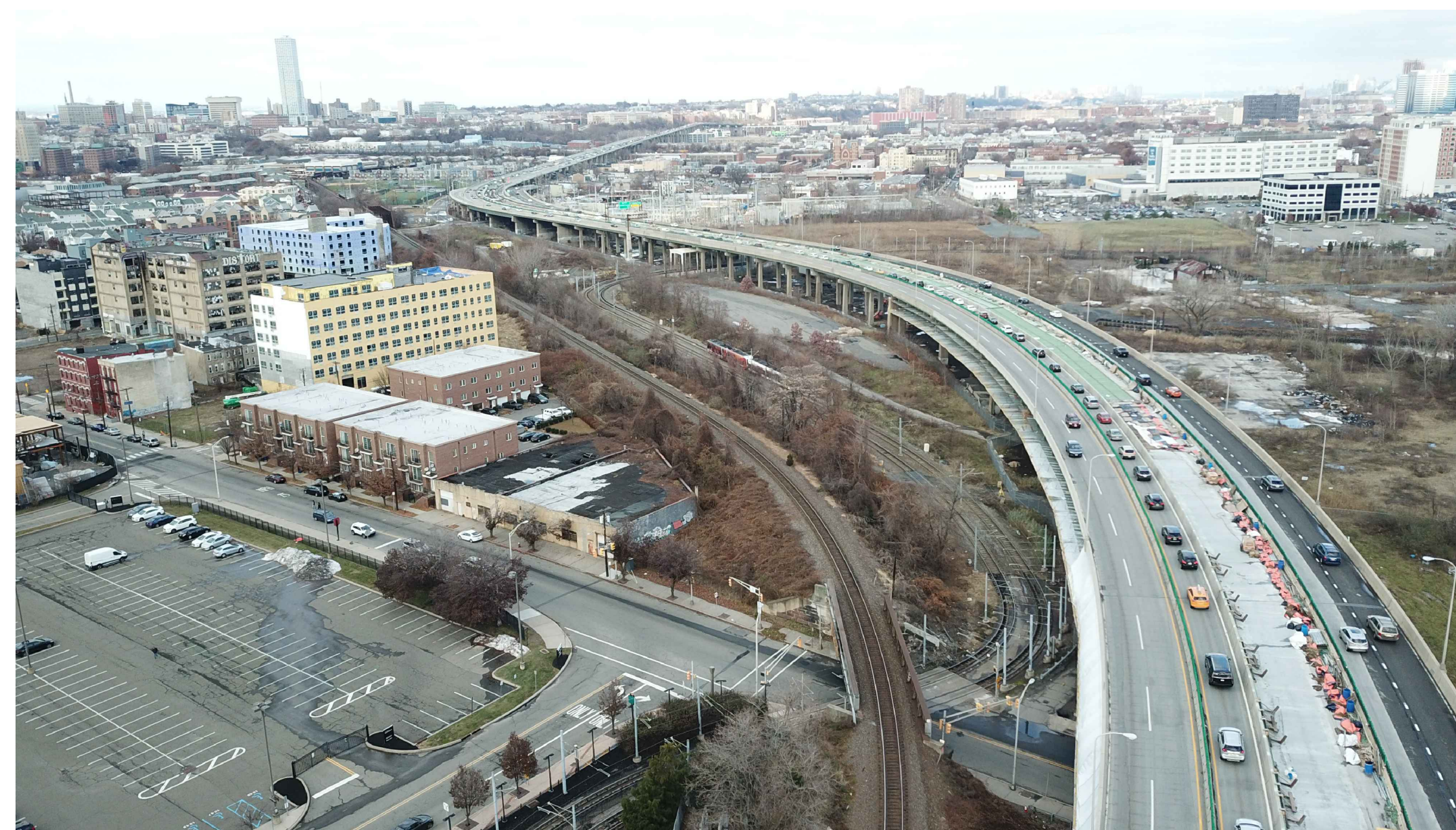
2 SITE PHOTO SOUTH EAST CORNER SCALE: N.T.S.
