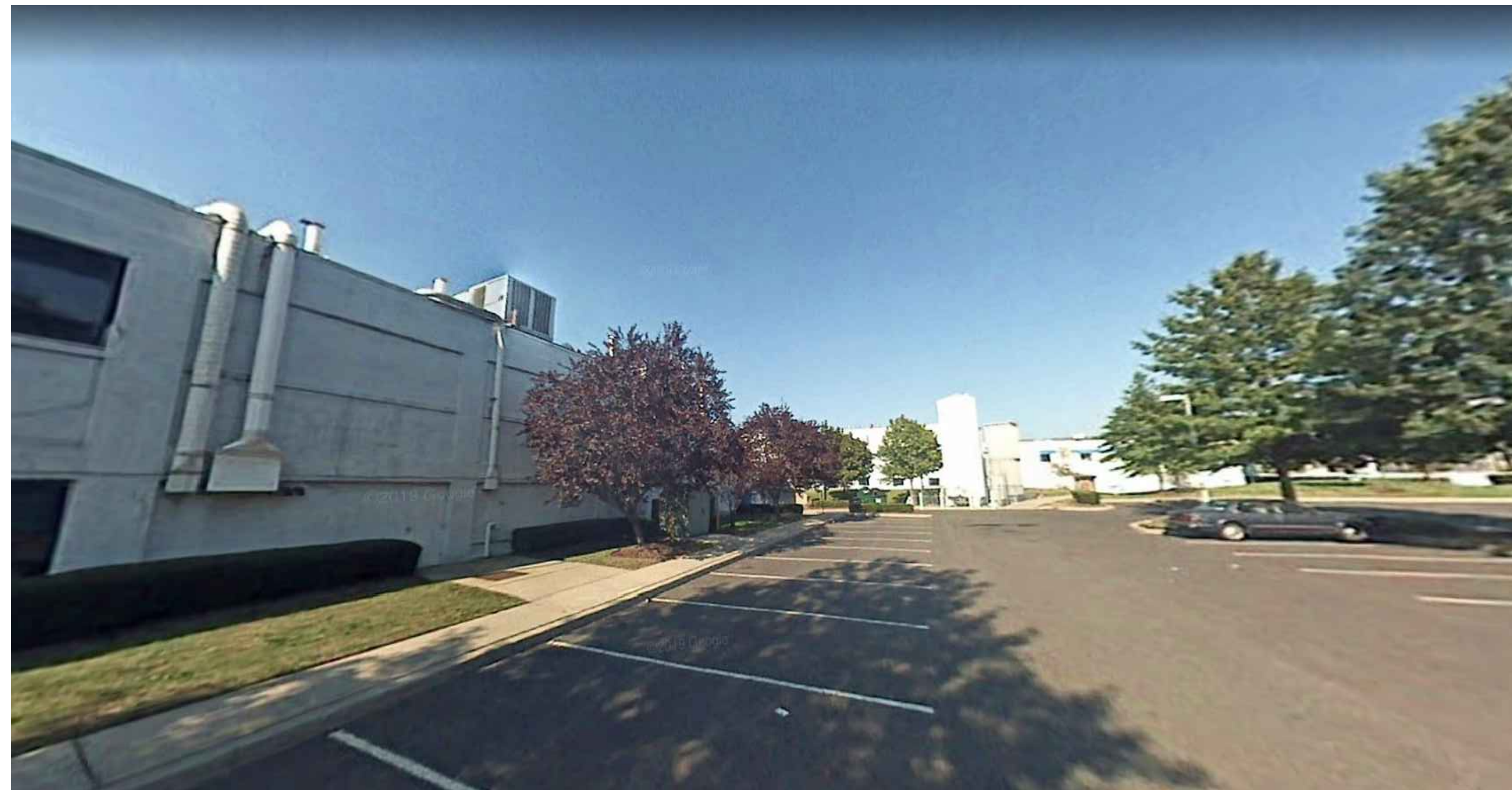
1 VIEW NORTHEAST - CLAREMONT AVENUE SCALE: N.T.S.
