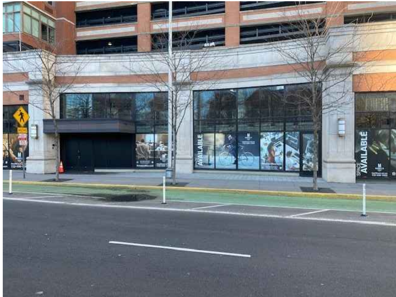
3 PHOTO @ EXISTING STOREFRONT SCALE : N.T.S.
