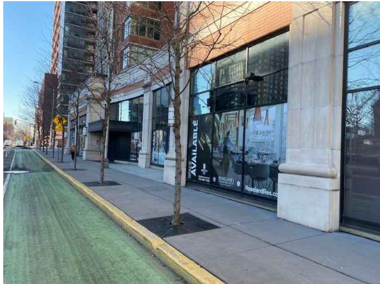
5 PHOTO @ EXISTING STOREFRONT SCALE : N.T.S.
