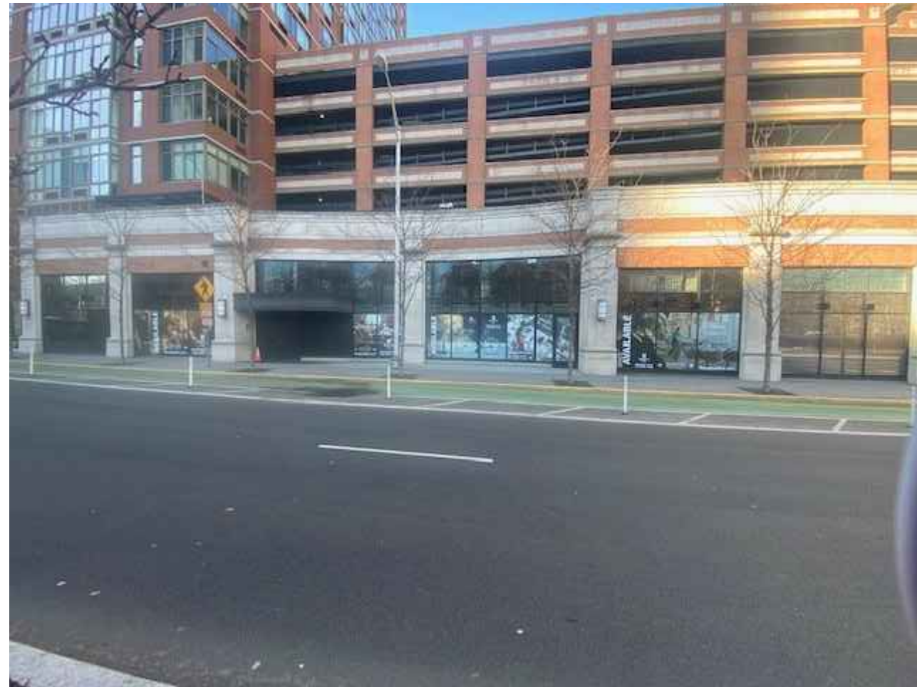
2 PHOTO @ EXISTING STOREFRONT SCALE : N.T.S.
