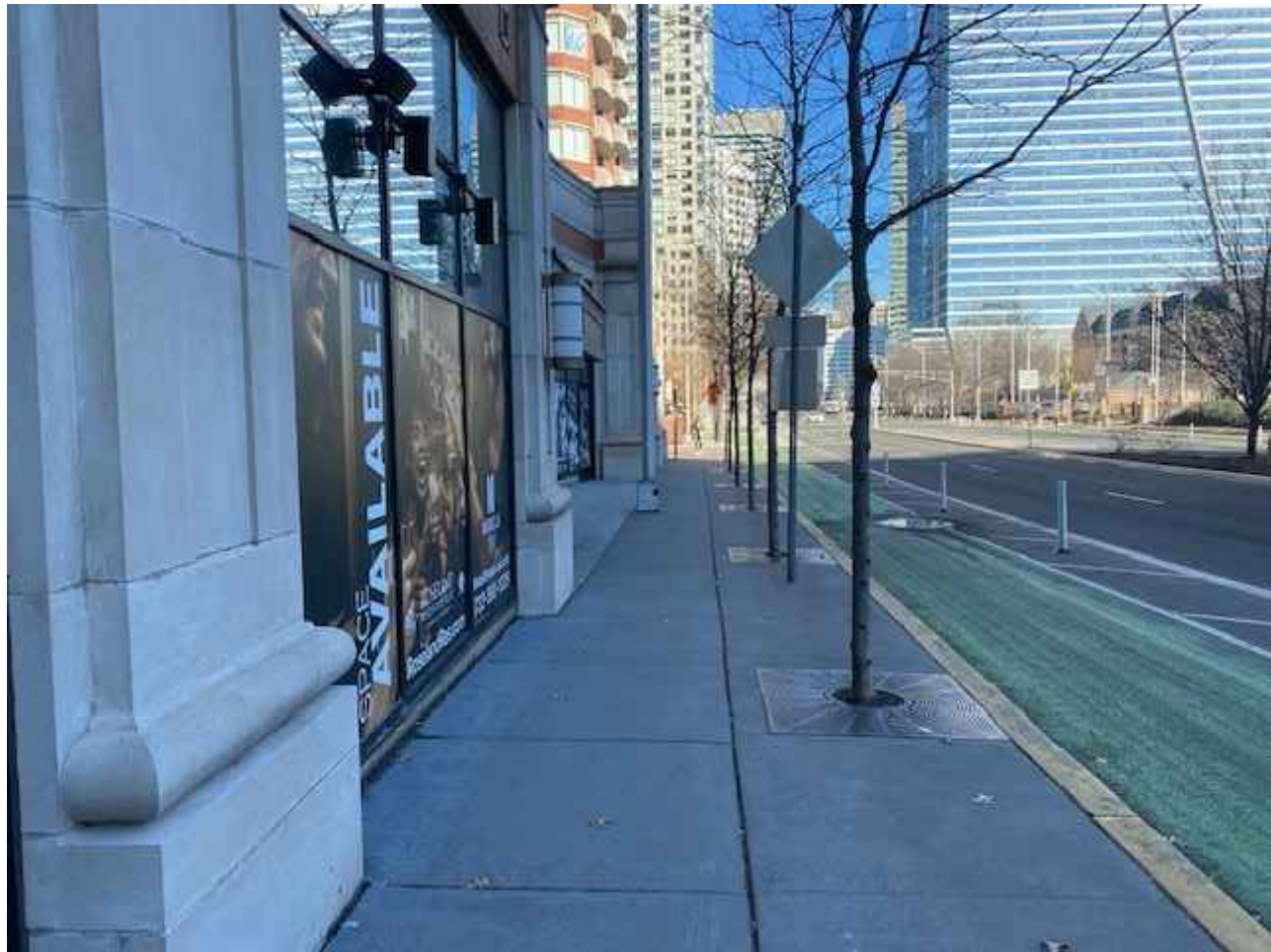
4 PHOTO @ EXISTING STOREFRONT SCALE : N.T.S.
